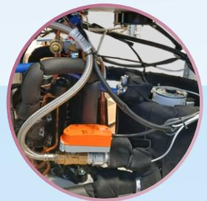
**Sistema opzionale** con valvola pressostatica elettronica **Brevetto Fintek** con algoritmo di programmazione alle varie temperature di acqua in ingresso e massimo risparmio.
